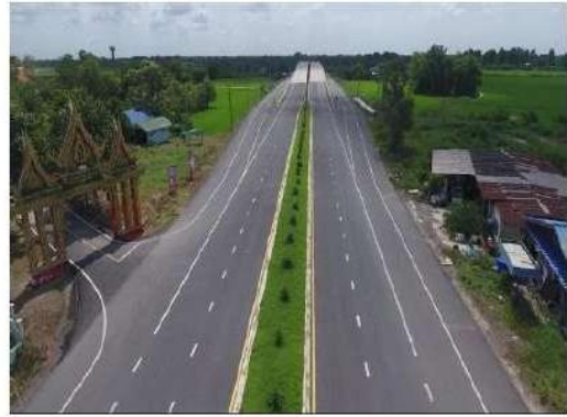
เสาไฟฟ้า
